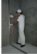
2- Fixação das guias nas lajes e colocação dos montantes perimetrais.
